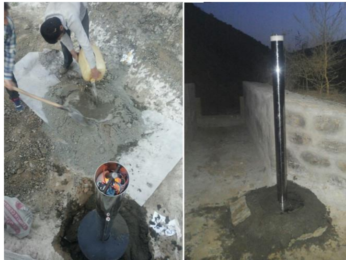
شکل ۲- مراحل نصب دستگاه سطح‌سنج تغییرات آب با حسگر مادون قرمز
