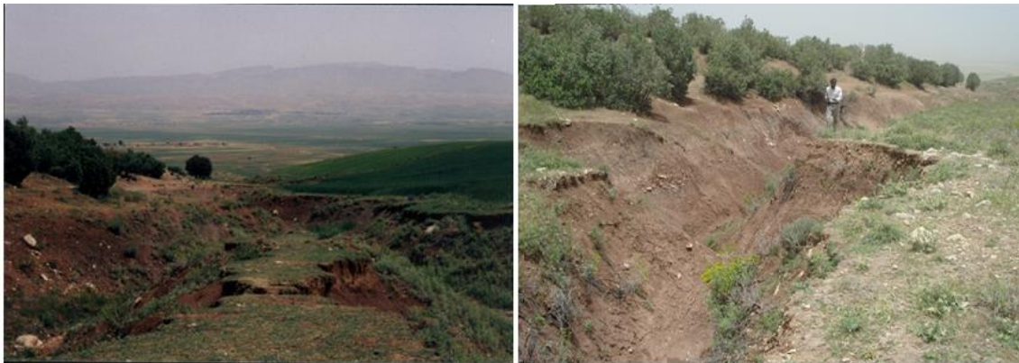
شکل ۶- نقش تبدیل اراضی مرتعی و تخریب پوشش گیاهی در گسترش خندق و تخریب اراضی در خندق‌های معرف سرفیروزآباد
