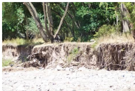
شکل ۳- فرسایش کناره‌ای در کرانه رودخانه
