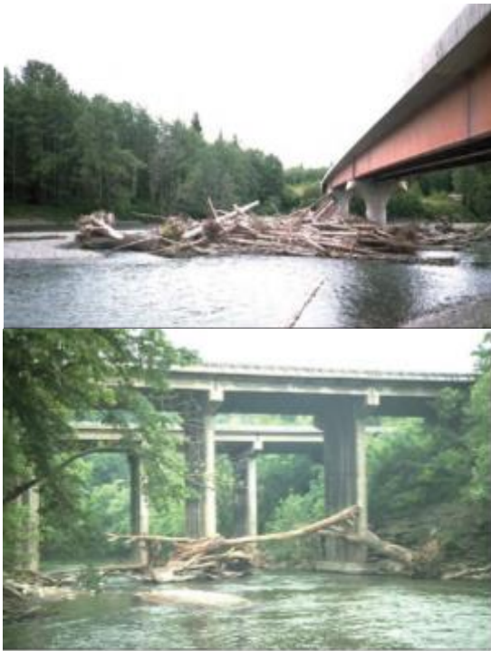
شکل ۱- نمونه‌هایی از تجمع الوار و انسداد دهانه پل
