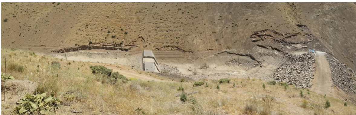
شکل ۲- محل مورد مطالعه، نمایی از آب بندان، سد ترکیبی سطحی-زیرزمینی و چکدم آبخیزداری در تاریخ ۹۵/۰۳/۲۴
